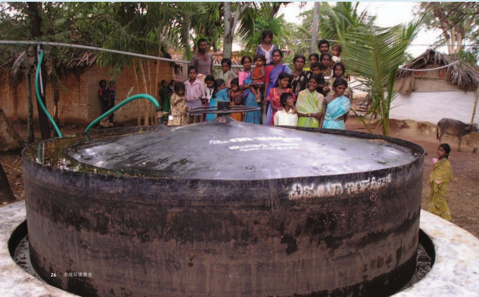
印度农村生物质能项目：集体沼气厂提供洁净的厨房用气
